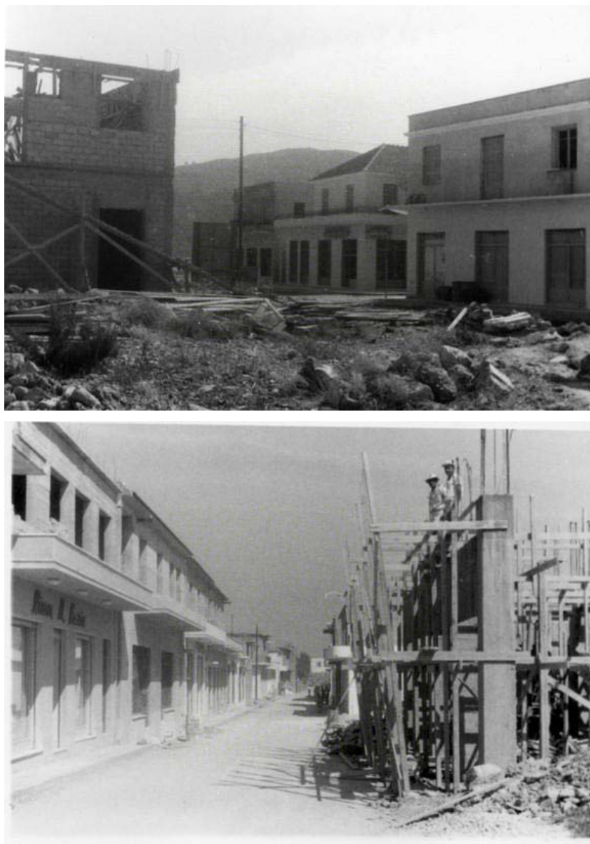
Εικόνα 5.3: Εικόνες από την ανοικοδόμηση των κατεστραμμένων κτιρίων του Αργοστολίου μετά τον καταστροφικό σεισμό του 1953.
