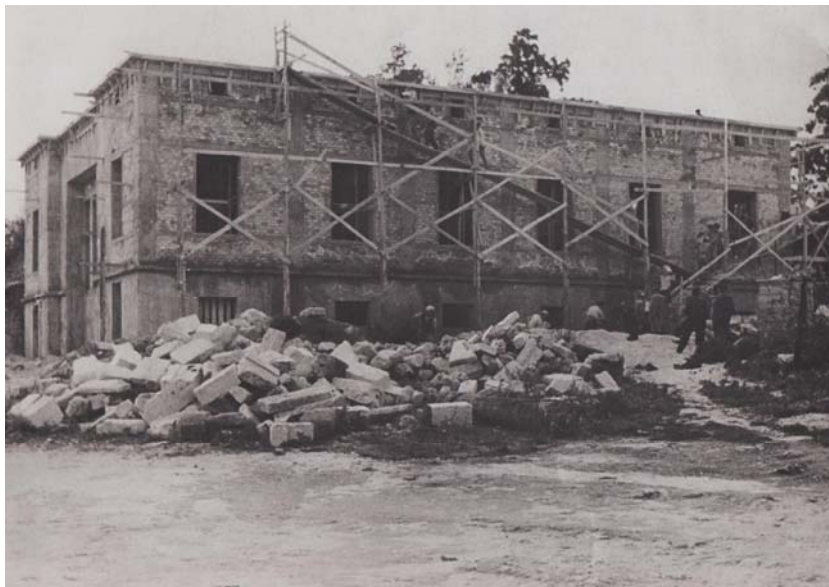
Εικόνα 5.1: Κοργιαλένειος βιβλιοθήκη Αργοστολίου κατά την ανοικοδόμησή της μετά το σεισμό του 1953.
